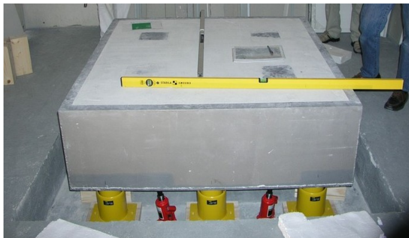
Obr. 66: Fotografie osazování izolační jednotky
